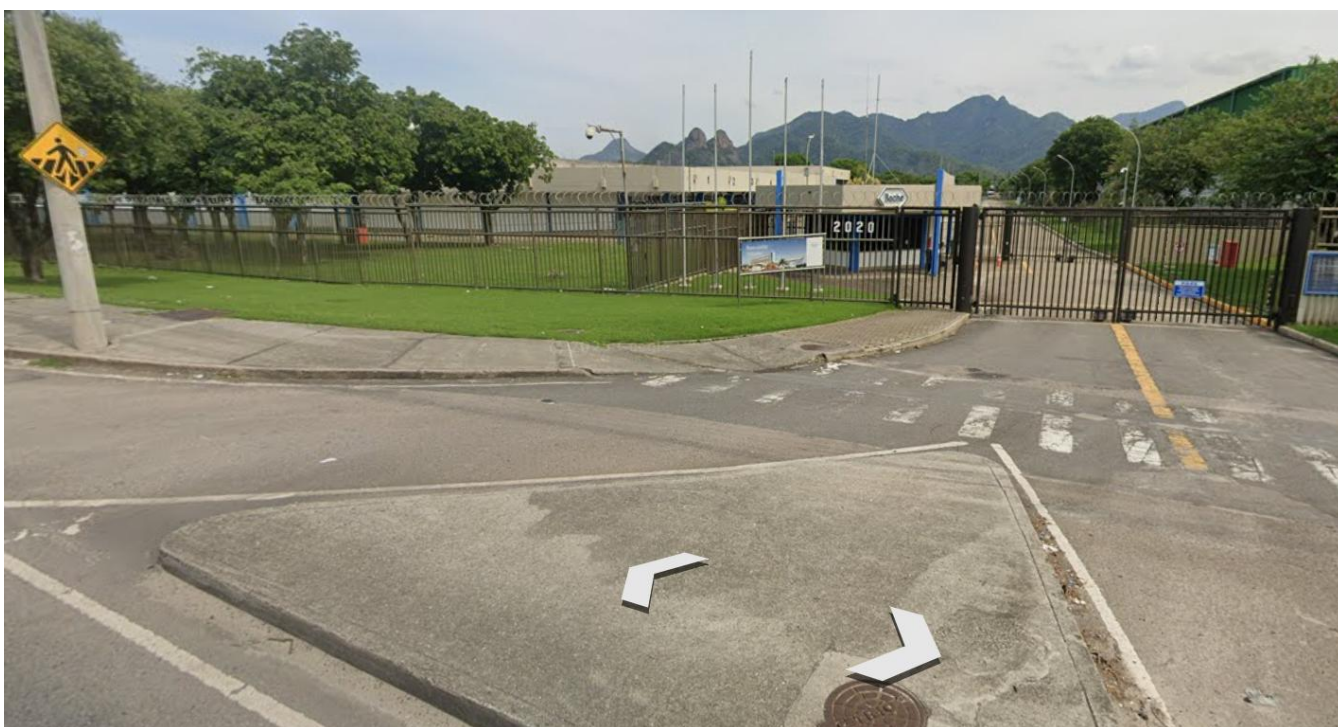
Vista frontal do imóvel, evidenciando acesso, volumetria e padrão de fachada.
